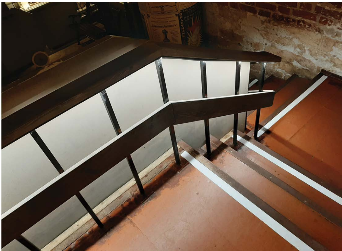
Светодиодные ленты, вмонтированные в поручни, помогают слабовидящим посетителям безопасно передвигаться по лестнице
